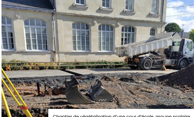
Chantier de végétalisation d'une cour d'école, groupe scolaire Condorcet à Angers. | © Jules Larguet, Plante & Cité
