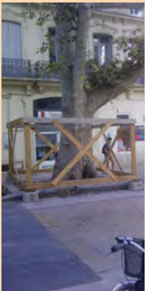
1 - Protection d'un Platane vis-à-vis des travaux de voiries Montpellier (34)
