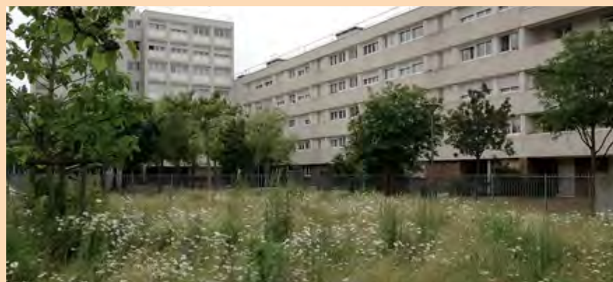
Commanditaire : SAES - Ville de Sevran (93) / Gestionnaire : Ville de Sevran (93) / Concepteur : Atelier de l'Ile, Bernard Cavalié, paysagistes / Année de réalisation : 2013 / Surface : 0,5 ha
