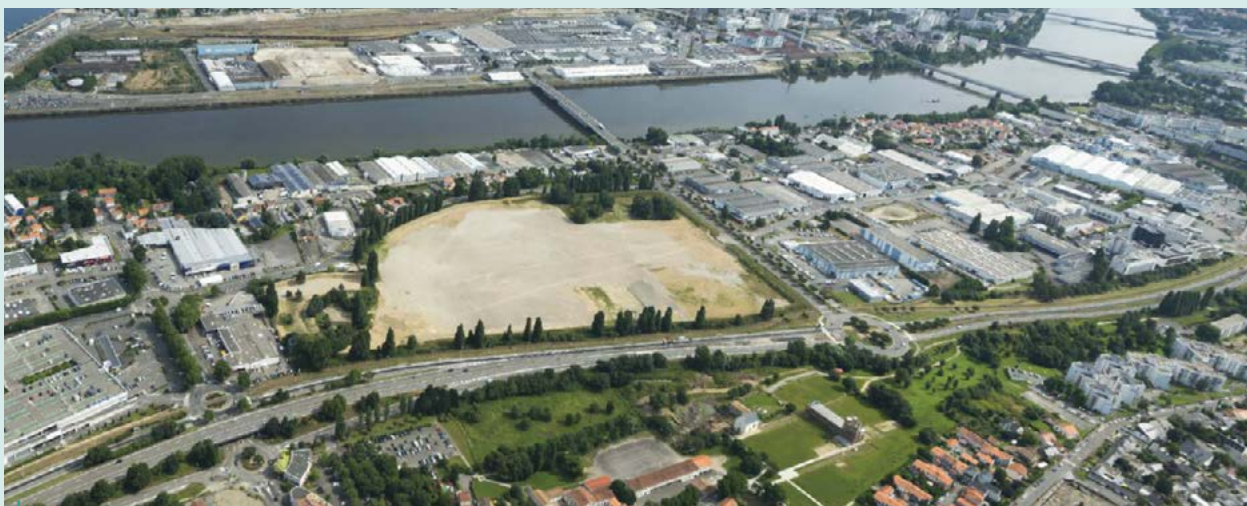
Vue aérienne de la ZAC Pirmil-Les Isles (44) comprenant la friche industrielle issue de la démolition des anciens abattoirs. Crédit : page de garde du rapport de présentation de la ZAC, Nantes Métropole (44).
